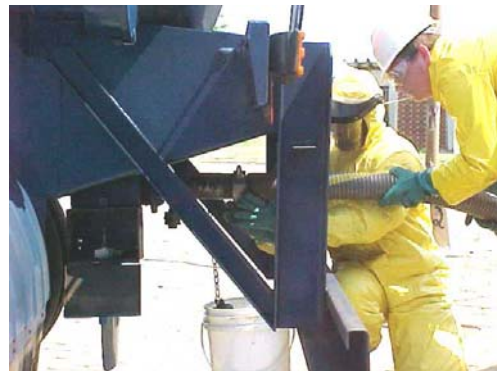
Foto 10 - Conexão do Mangote
