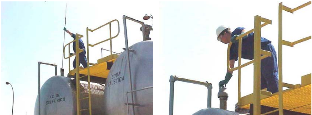
Fotos 3 e 4 - Sondagem Inicial do Nível do Tanque e Fechamento da Tampa de Inspeção
